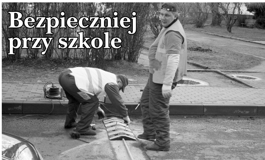
Pracownicy Zakładu Usług Komunalnych zamontowali ograniczniki prędkości na ulicy przy szkole.
