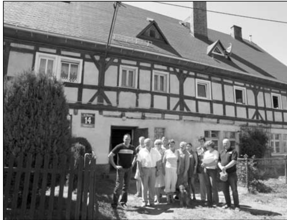
Coraz więcej wspólnot mieszkaniowych podejmuje decyzję o remontach dachów. Na zdjęciu mieszkańcy domu przy ul. Bocznej 14 na odbiorze prac. Wykonawcą prac była firma p. Janusza Boryńca ze Szklarskiej Poręby, z której robót mieszkańcy są bardzo zadowoleni
