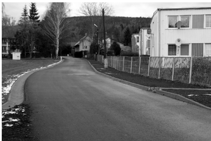
Ulica 1 Maja po remoncie.
