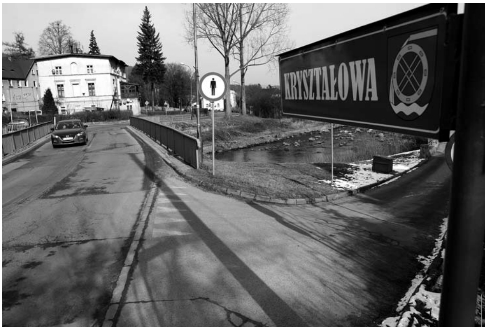
Kanalizacja zostanie wybudowana na ul. Kryształowej na odcinku do mostu na Kamiennej (do budynku 101).
