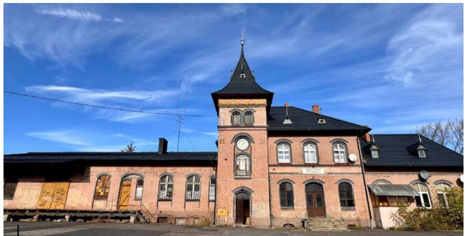
Remont dachu dworca kolejowego to jedna z największych inwestycji, zrealizowanych w 2025 roku.
