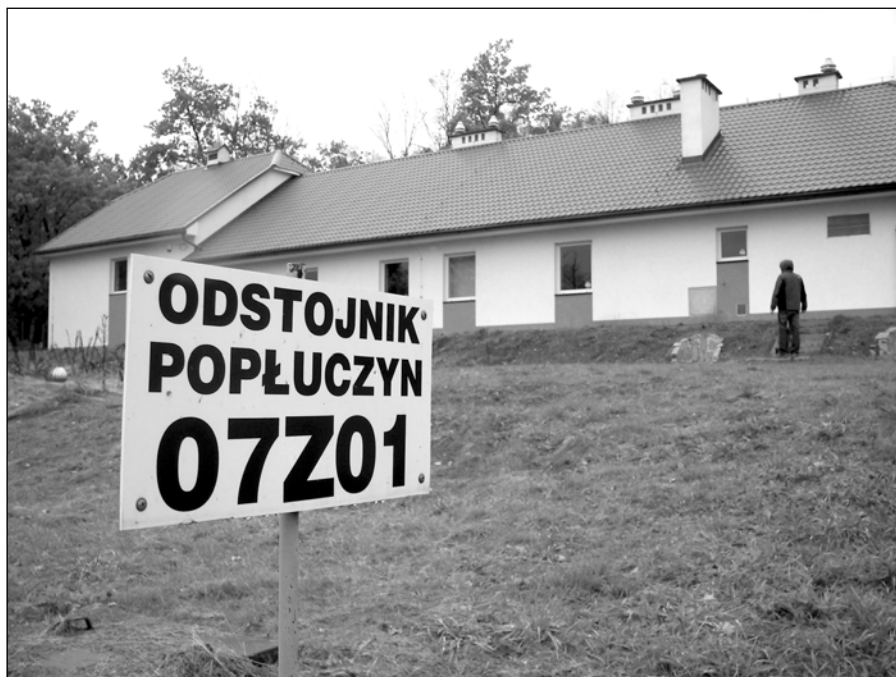
Stacja Uzdatniania Wody jest sukcesywnie modernizowana
