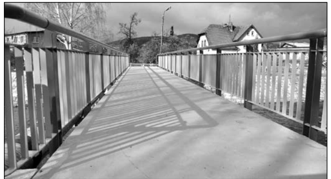
Kładka została odbudowana
