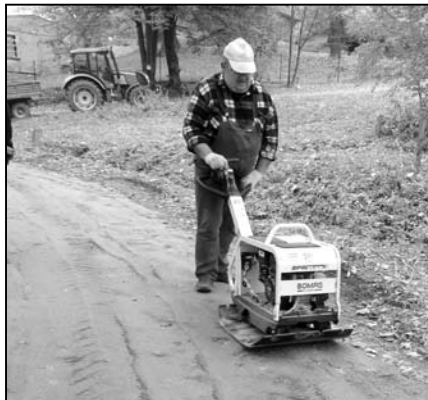
Drobny, ale niezbędny zakup – bardzo przydatna zagęszczarka
