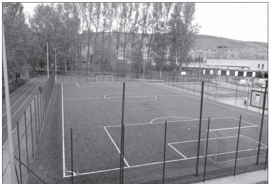
Jedną z największych inwestycji w ubiegłym roku była budowa kompleksu boisk Orlik.
