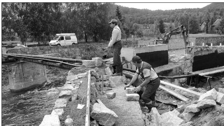
Zgodnie z terminem przebiegają prace przy budowie kładki na Kamiennej. – Nie będzie opóźnień w zakończeniu prac – obiecuje kierownik budowy p. Jan Szymański
