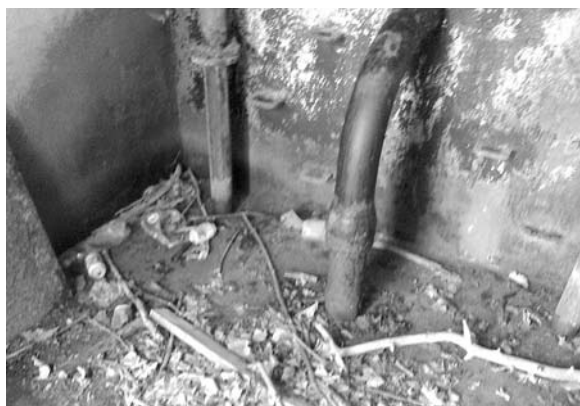
Widok zbiornika wody po otwarciu zaspawanych drzwi zewnętrznych.
