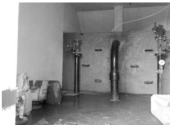
Widok zbiornika retencyjno-redukcyjnego „Piechowice” po zakończeniu prac odtworzeniowych.
