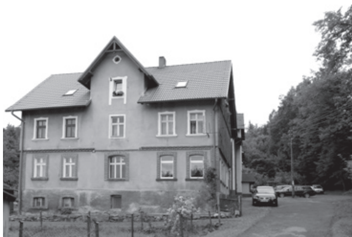
Wyremontowany dach budynku przy ul. Wolskiej 1 w Piastowie.
