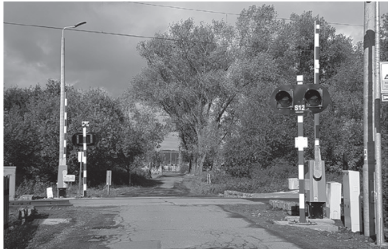
Na przejeździe przez ulicę Polną zamontowano nowe półrogatki.
